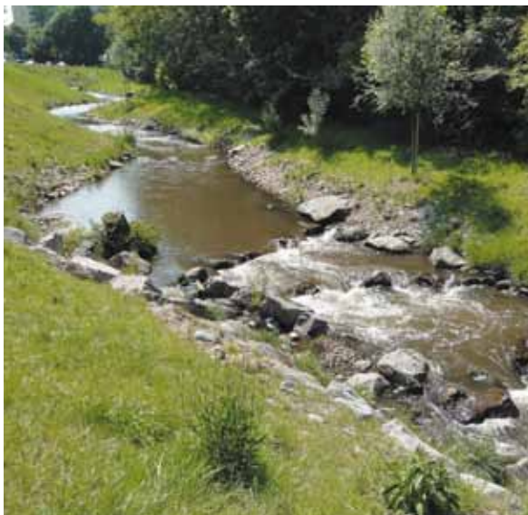
Trompetergraben in Germersheim nach Umgestaltung
