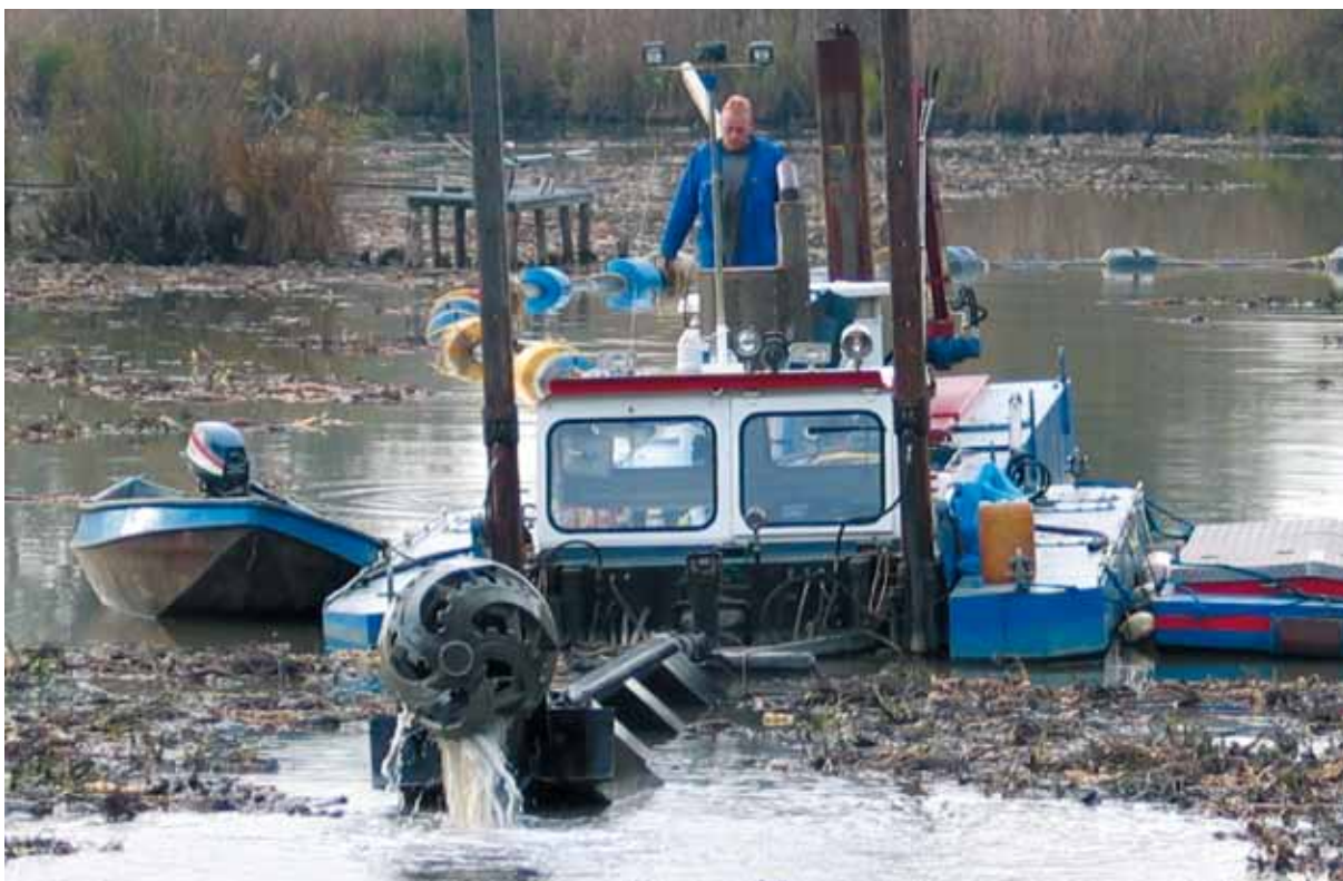
Schwimmbagger bei der Entschlammung des Neuburger Altrheins.
