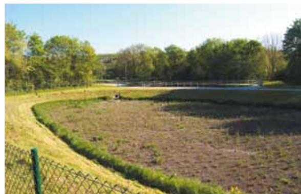
Retentionsbodenfilter: Reinigt das Mischwasser und gibt es gedrosselt wieder an das Gewässer ab.
