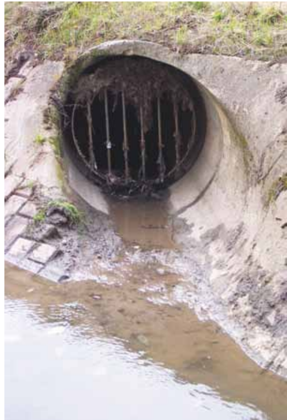
Regenüberlauf: Bei Regen setzt ein Abwasserschwall ein, der das Gewässer hydraulisch und stofflich belastet.
