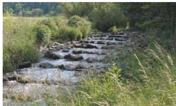
Ehemaliges Belgweiler Wehr am Simmerbach mit neuer Sohlgleite, die jetzt für Wanderfische durchgängig ist.
