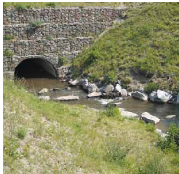
Neuer Straßendurchlass Trompetergraben in Germersheim
